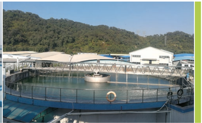
Sewage treatment facility in Xinhui 新會污水處理設施
