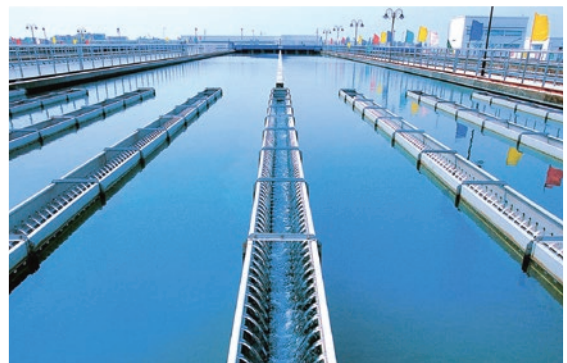
上高潤泉沉澱池
